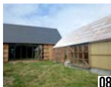
Maison-Ploubazlanec Christophe Gauffeny 15 kWh/(m 2 .an)
