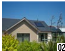
Maison - Fréhel Entreprise Le Tohic 14 kWh/(m 2 .an)
