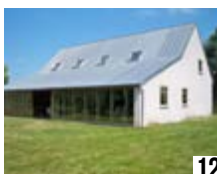
Rénovation - Pordic Christophe Gauffeny 20 kWh/(m 2 .an)
