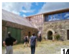
Rénovation - St Péver Christophe Gauffeny 9 kWh/(m 2 .an)
